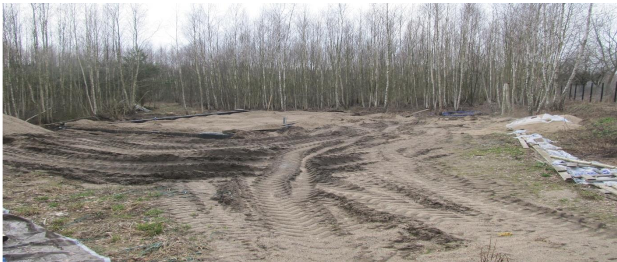
Zdjęcie 5. Trwające prace budowlane na działce nr 451/31
