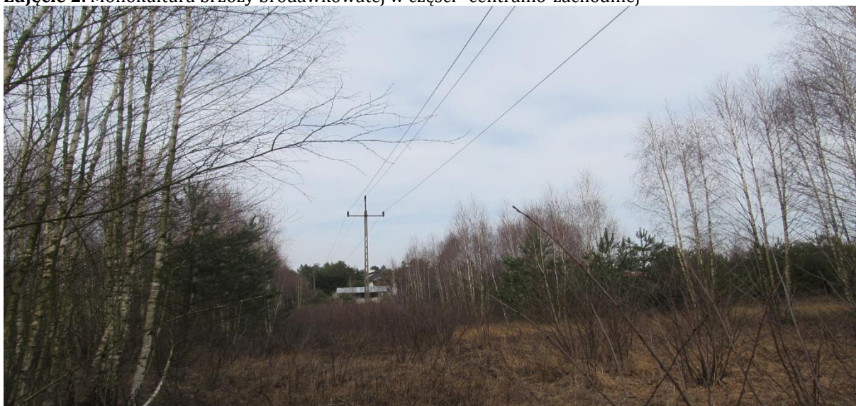
Zdjęcie 3. Linia elektroenergetyczna przebiegająca przez północno-zachodnią część obszaru
