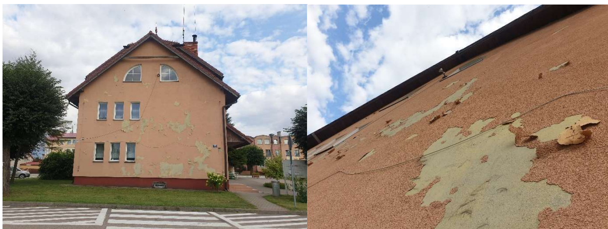
Zdjęcie nr 1 i 2 widoczne odspojenia wyprawy elewacyjnej
